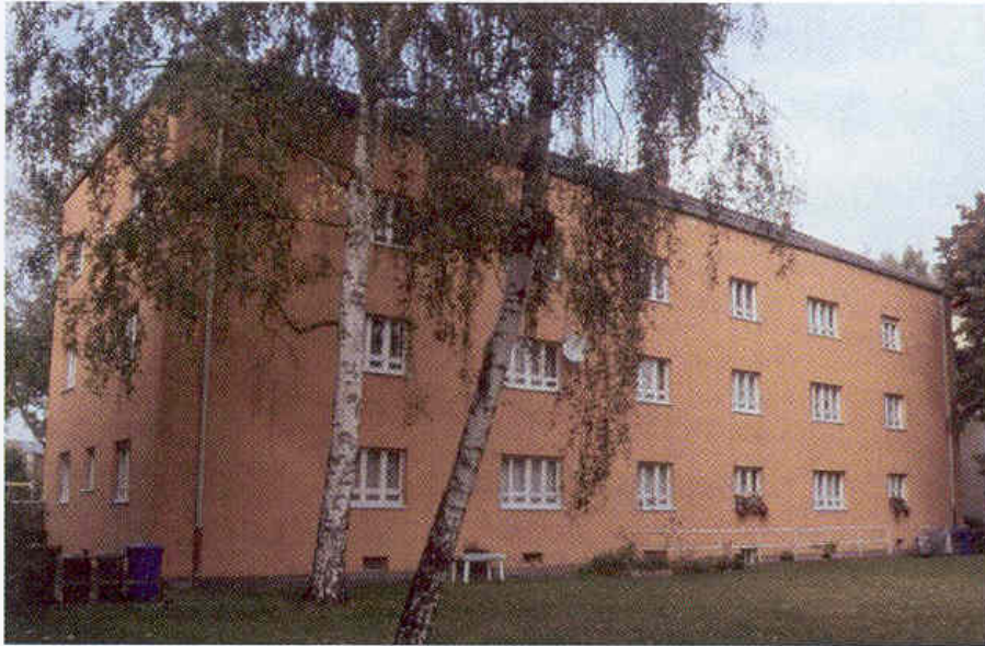
Abb. 1: Vor der Sanierung
