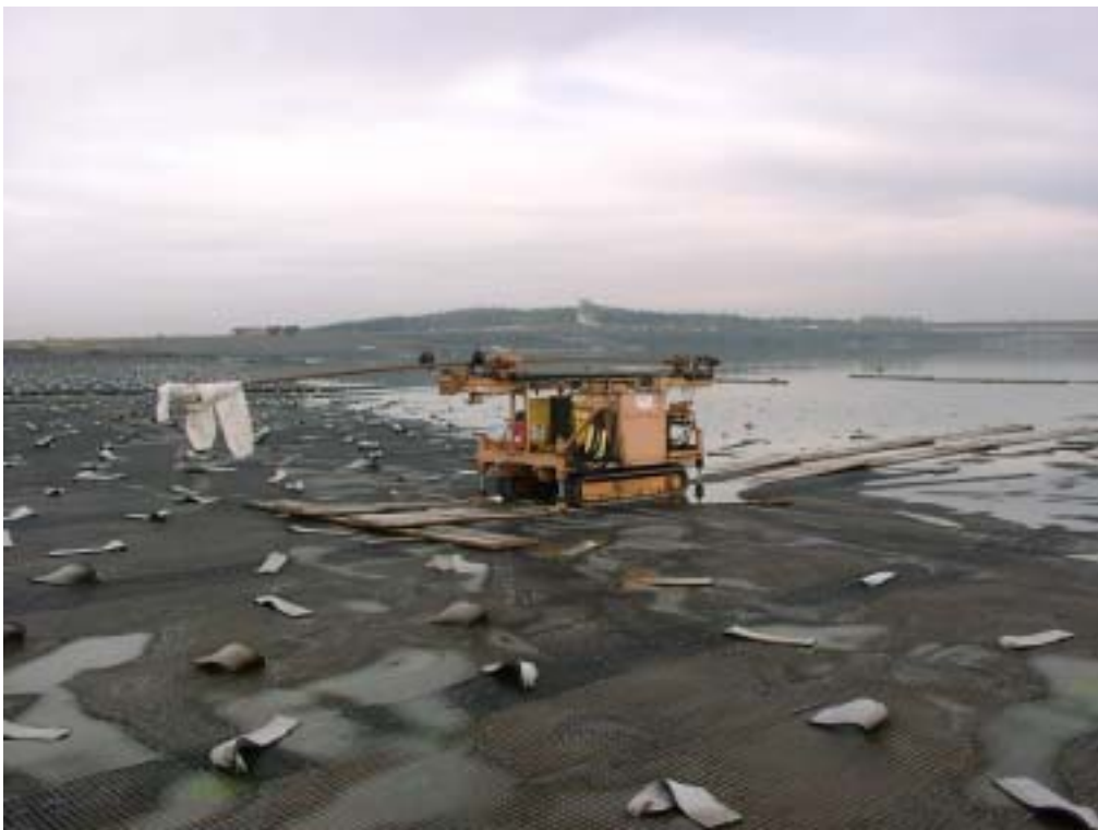
Abb. 8: Einbringen von Dräns
