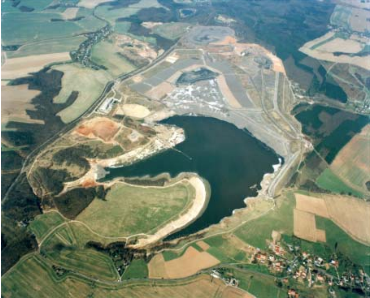
Abb. 4: Luftaufnahme April 2003, begonnene Dammanflachung und Plateaugestaltung bei gleichzeitiger Freiwasserentfernung und Zwischenabdeckung
