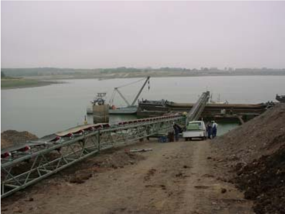
Abb. 10: Subaquatische Arbeiten mit Bandanlage, Klappschute und Beiboot
