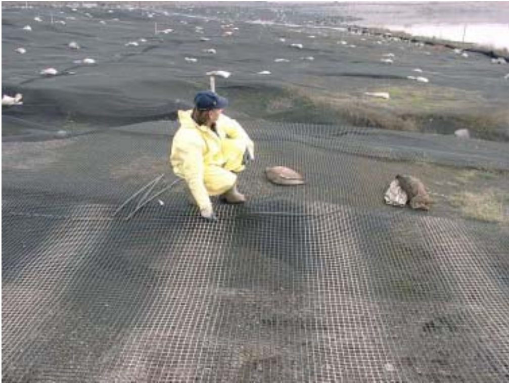
Abb. 7: Aufgebrachtes Geogitter
