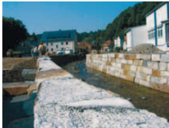
Abbildung 20: Dieselbe Ufermauer der Müglitz in Glashütte 2004 (Foto: LTV, 2004)
