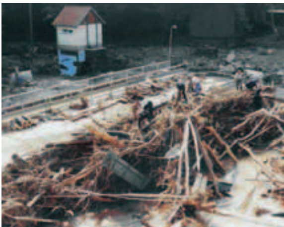
Abbildung 4: Vollständige Erosion des Bahndammes im Müglitztal. Beachtenswert ist die freigelegte alte Stützmauer, die dem Fluss früher ein breiteres Bett einräumte. (Foto: LTV, 2002)
