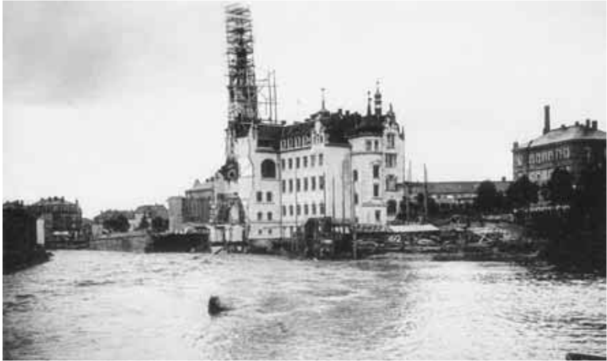
Abbildung 13: Nach dem Hochwasser 1897 zerstörter Flügel des Löbtauer Rathaus an der Weißeritz (Foto: LfUG)
