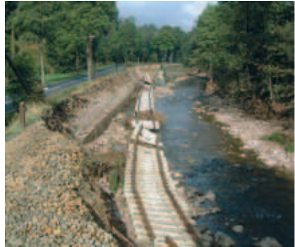
Abbildung 4: Vollständige Erosion des Bahndammes im Müglitztal. Beachtenswert ist die freigelegte alte Stützmauer, die dem Fluss früher ein breiteres Bett einräumte. (Foto: LTV, 2002)
