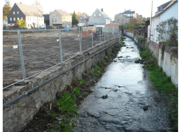
Bauzustand nach Abriss der Gebäude und vor dem Schleifen der Ufermauer, Oktober 2009
