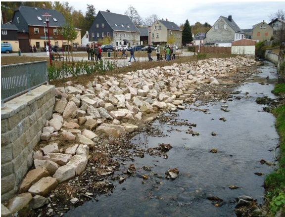
Zustand nach Fertigstellung der Maßnahme im November 2010
