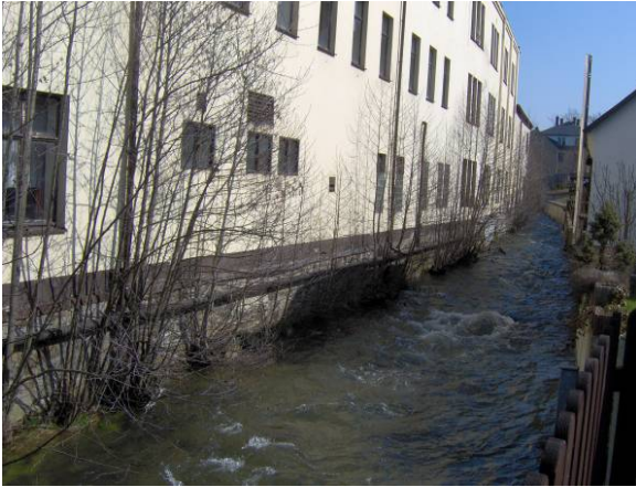
Zustand vorher mit Blick auf die ehem. Kronkorkenfabrik und entgegen der Fließrichtung der Großen Mittweida
