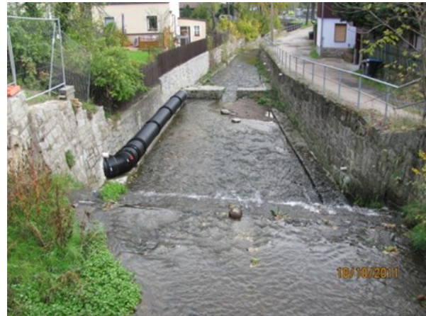
Wehr und unterwasserseitiger Gewässeranschluss vor Rückbau
