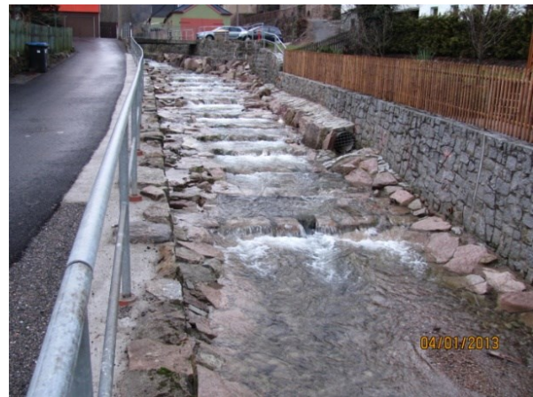
Rampe mit Becken nach Fertigstellung / Blick Richtung Oberstrom
