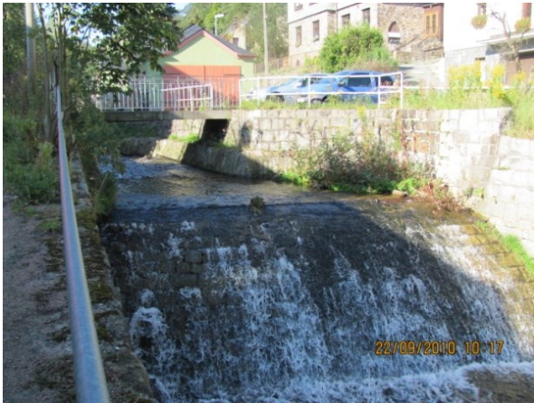
Wehrbestand vor Rückbau
