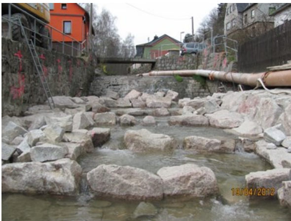
Probelauf im Bereich des unteren, fertiggestellten Rampenabschnittes / Blick Richtung Oberstrom
