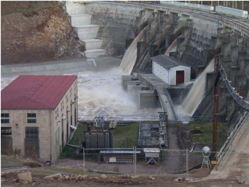
Talsperre Kriebstein, 19.03.2005, 18:30 Uhr, Abfluss ca. 380 m 3 /s
