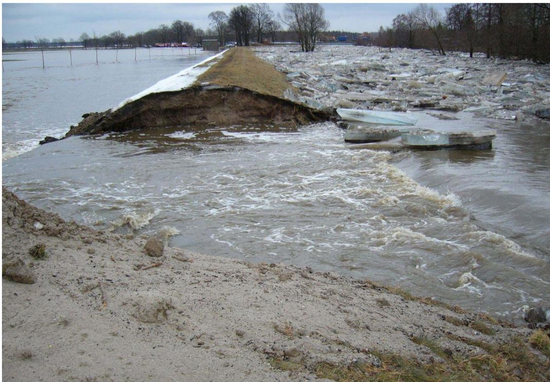
**Abbildung 1.8: Deichöffnung am Deich der Schwarzen Elster ca. 350 m unterhalb der Brücke Tätzschwitz (Foto: SMUL, 2006)**
