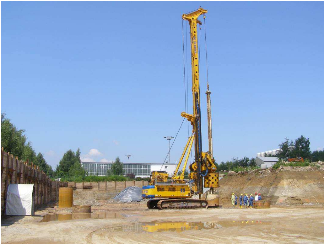
Abb. 3: Bodenaustausch in der Sanierungszone 2 im Großlochbohrverfahren, auf der Oberkante des Chemnitzschotters / des 1. Grundwasserleiters nach dem Beräumen des Grubensystems (Abb. 2); Foto Dr. Wolff
