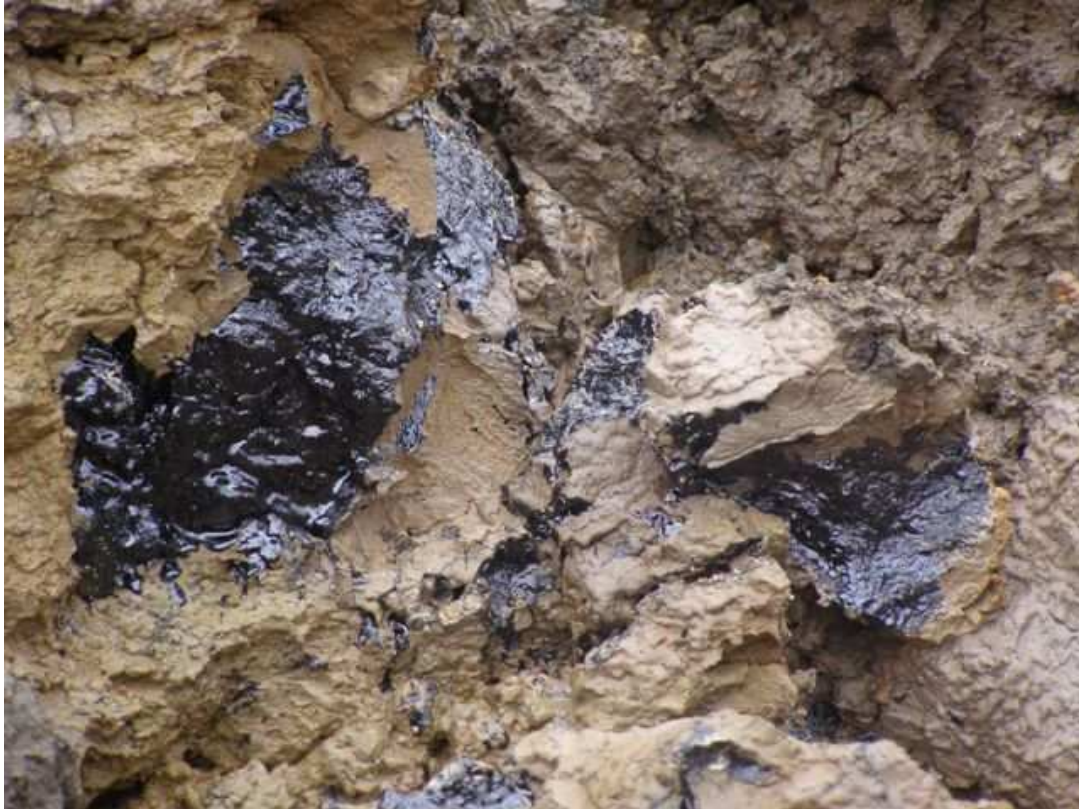
Abb. 5: „Spalten“ und „Rissen“ mit Teeröl durchtränkter Oberflächen des Sekundärporengefüges (Polyedergefüge) in bindigen Bodenmaterialien (Kohärentgefüge mit Entlastungsbrüchen) ca. 5 m unter Geländeoberfläche; Foto Dr. Wolff
