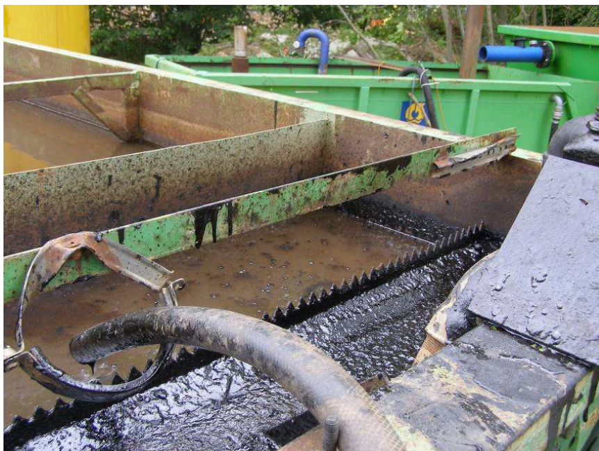
Abb. 7.: Wasserreinigungsanlage; Foto Dr. Wolff
