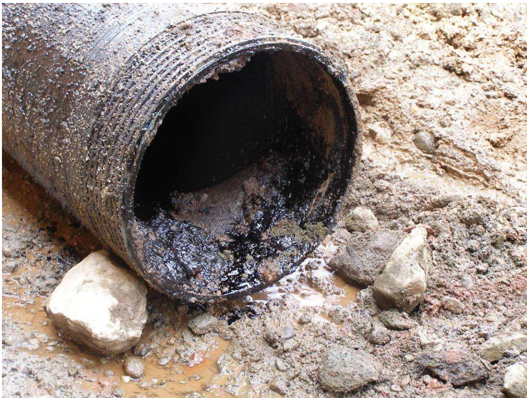
Abb. 6: Baugrubenwasserhaltung; mit Teerölen zugesetztes Filterrohr eines Schwerkraftbrunnens, Foto Dr. Wolff
