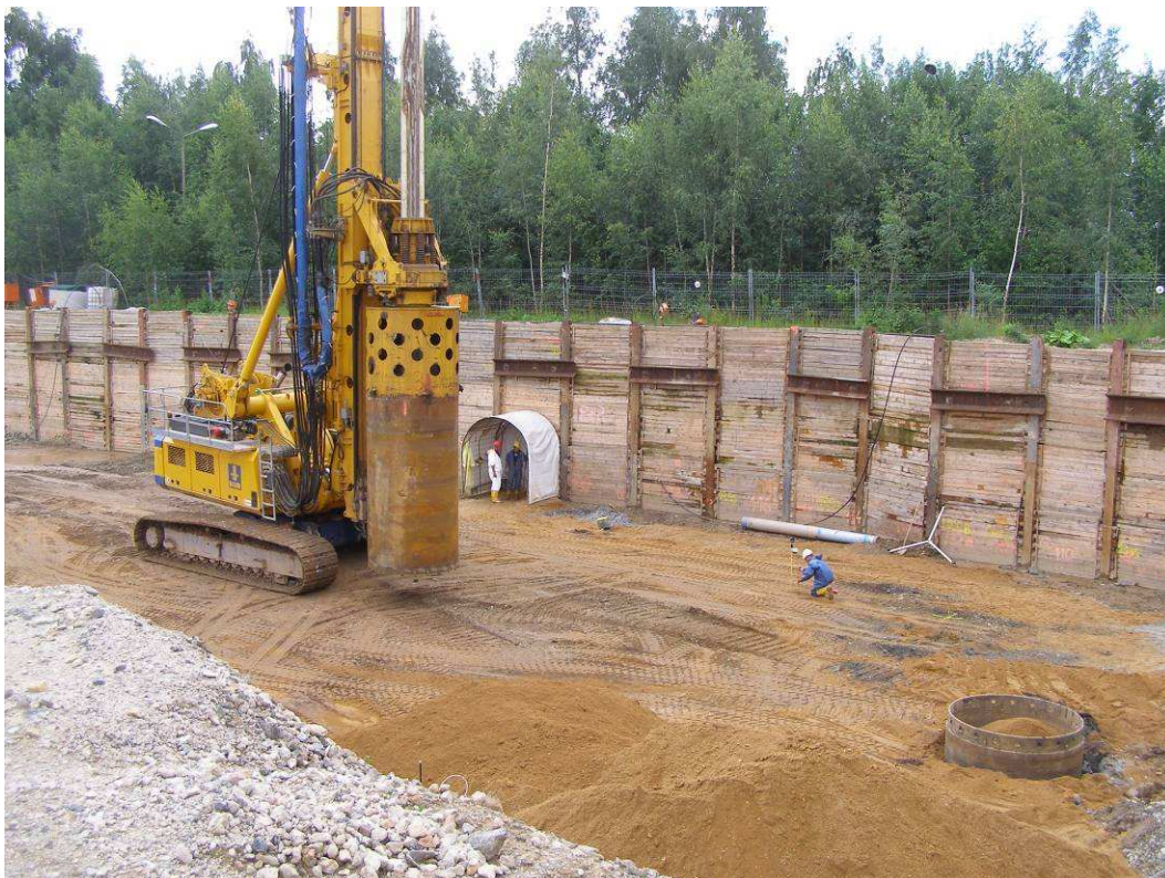
Abb. 4: Bodenaustausch in der Sanierungszone 2 im Großlochbohrverfahren, auf der Oberkante des Chemnitzschotters / des 1. Grundwasserleiters; Foto Dr. Wolff
