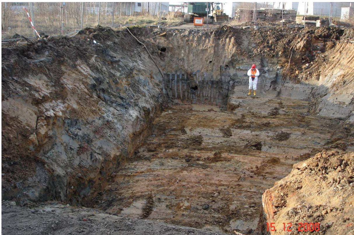
Abb. 4: Sanierungszone 3, Standort des ehemaligen Apparatehaus; Foto Dr. Wolff
