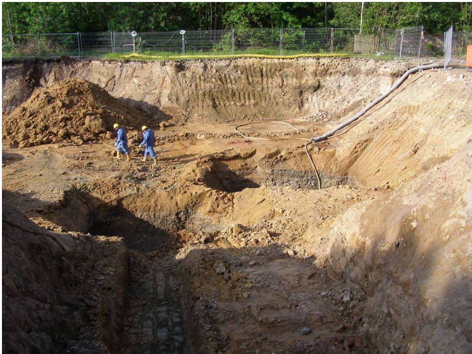
Abb. 1: Sanierungszone 1, Standort der ehemaligen Benzolanlage. Die punktuellen Vertiefungen zeigen die zusätzlich ausgekofferten Bereiche von Teeröl kontaminierten Materialien im 1. Grundwasserleiter (Chemnitzschotter); Foto Dr. Wolff
