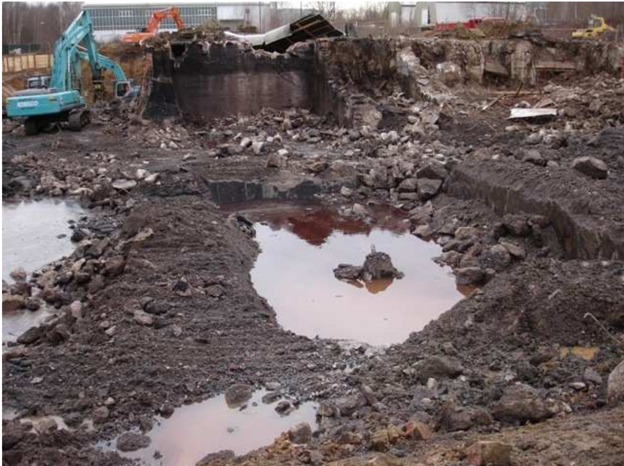
Abb. 2: Abriss des Grubensystems in der Sanierungszone 2. Die bräunlich – rote Wasserfärbung zeigt die hohe Konzentration an Phenolen im angeschnittenen Grundwasserkörper (Chemnitzschotter), Foto Dr. Wolff
