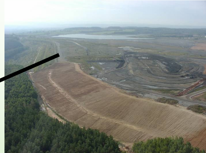
Region III Aufbereitungsanlage Crossen
