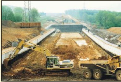
Bodenaushub im Rahmen von Baumaßnahmen
