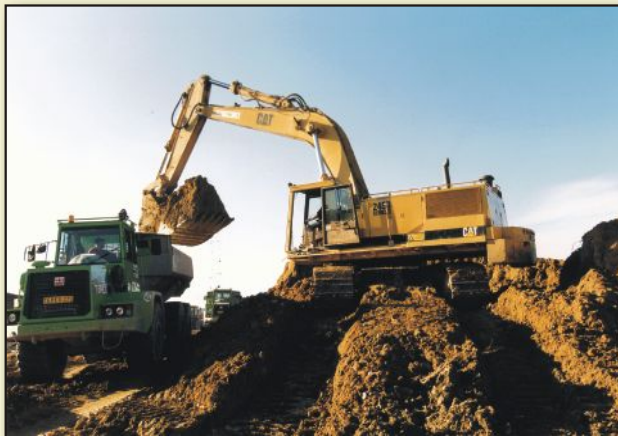
Aushub von Bodenmaterial
