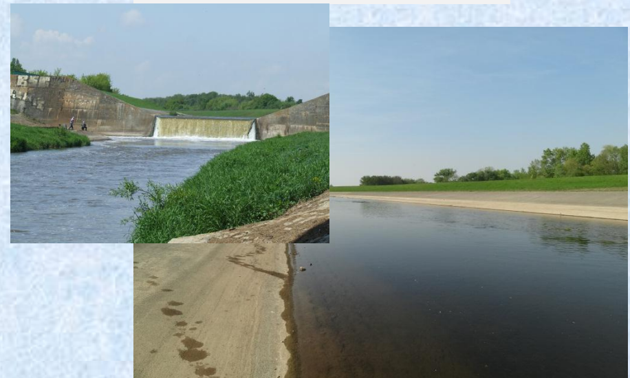
WE, A05, Verlegestrecke
