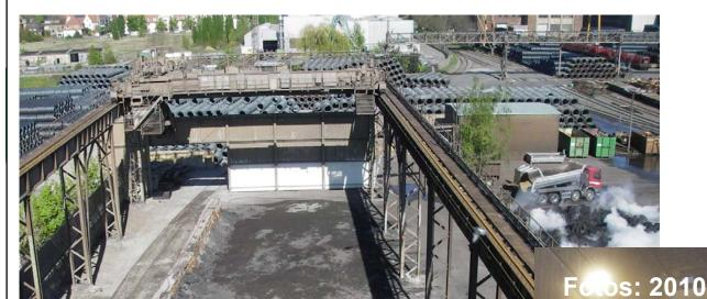
neues Schlackebeet mit Absaughaube, Einbindung in Entstaubungssystem
