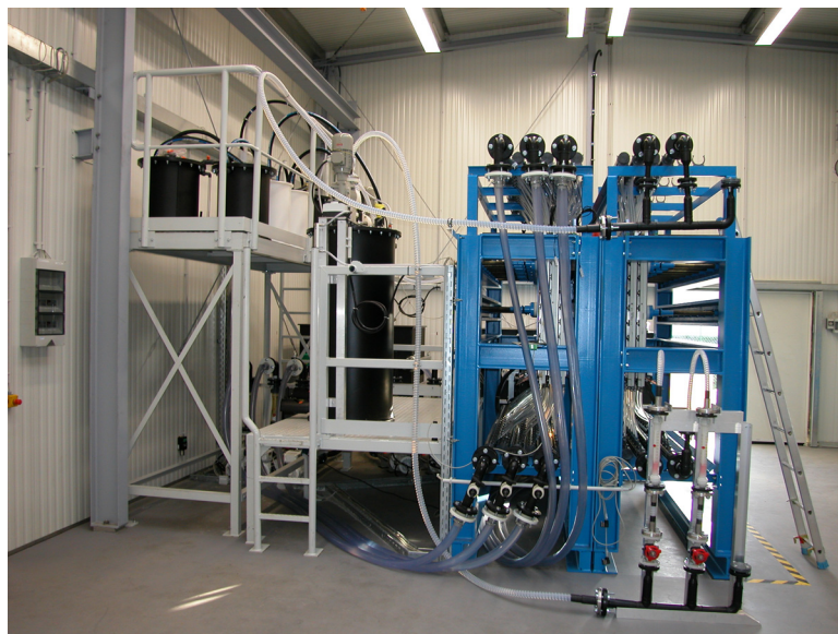
Versuchsanlage VKTA (Quelle: VKTA)
