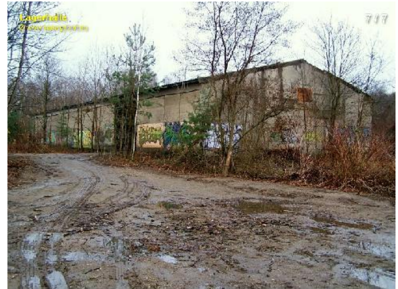
ehemalige Halle für mit Munition beladene LKW
