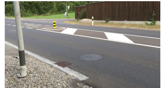
Neue Deckel Einbautoleranz: Max. 2-4 mm tiefer
