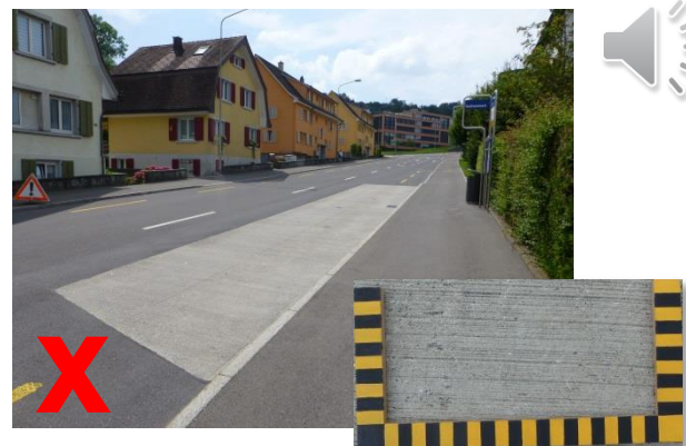
Standort C Querbeseinstich und Fugen ( sehr laut )
