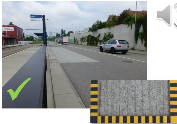
Standort A Längsbesenstich ( relativ leise )
