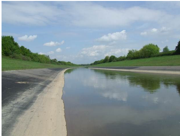
Foto: Weiße Elster – Verlegestrecke, km 55+500
