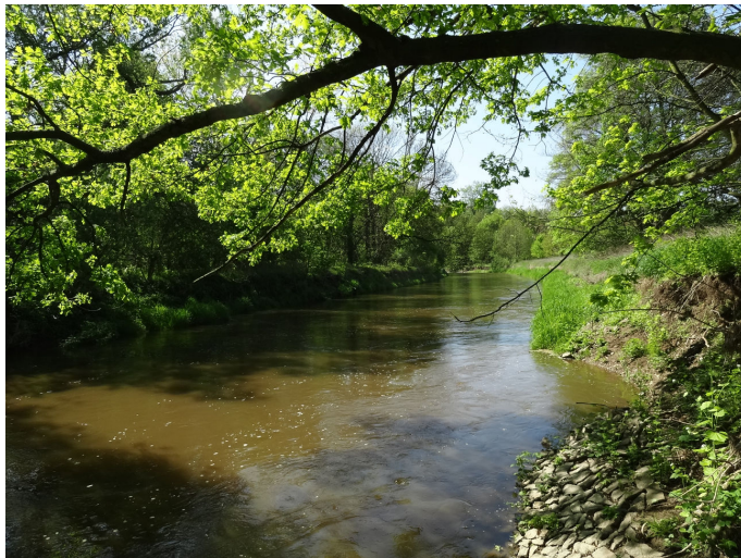
Foto: Weiße Elster oh Leipzig, defektes Deckwerk
