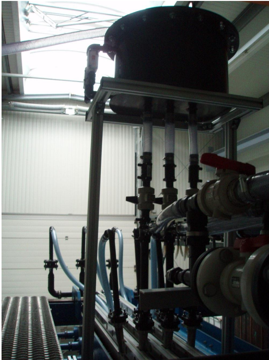
Abbildung 6: Ausgleichsbehälter im Ablauf der Zellen
