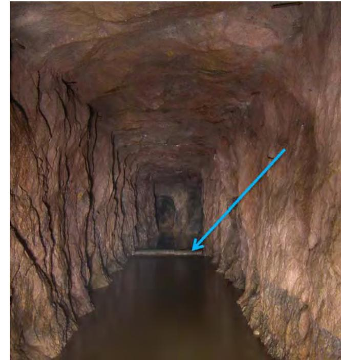
01.11.2011 neue Sohlschwelle mit Sedimentationsstrecke/Strecken-sumpf im Tiefen Hilfe Gottes Stolln
