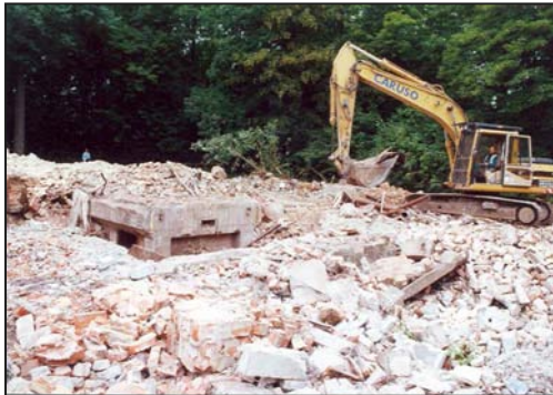
ehem. Bauhof agra Leipzig
