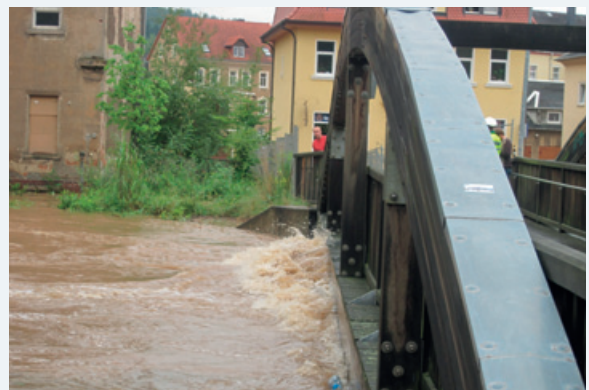
Abbildung 9-60: Einstau Brücke Hönickasteg (Foto: LTV)
