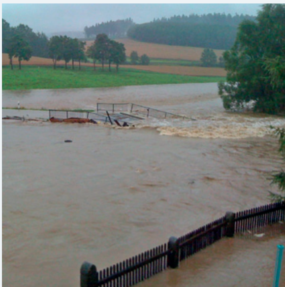
Abbildung 9-46: Überströmen (Foto: Hr. Baldauf)
