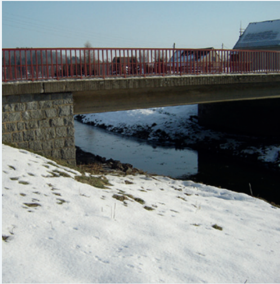
Abbildung 9-44: Vorhandenes Brückenbauwerk bis August 2010 (Foto: SBA Bautzen)
