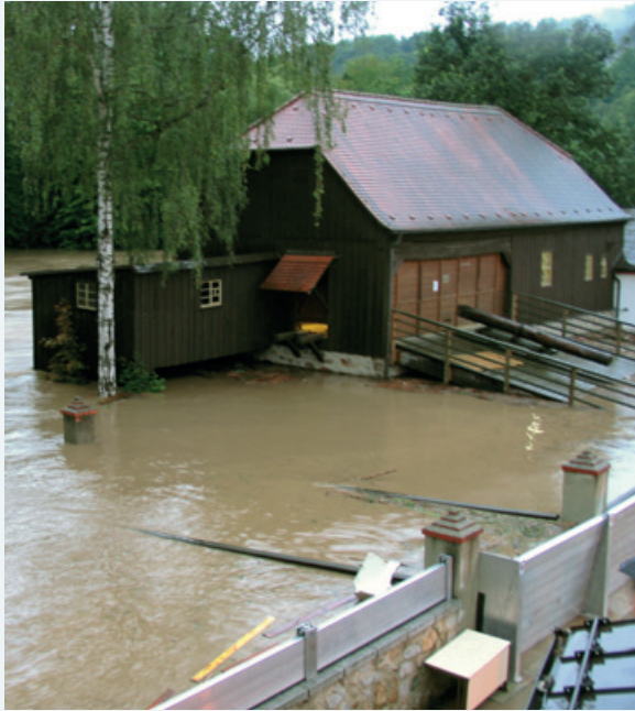
Abbildung 9-8: Ostritz Kloster. Aufbau mobiler Hochwasserschutz-elemente am 07.08.2010, gegen 16:00 Uhr (Foto: Kloster St. Marienthal)
