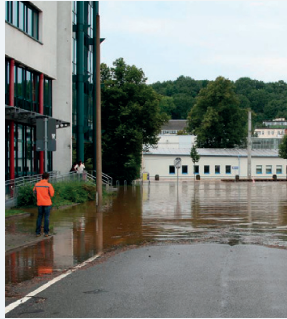
Abbildung 6-8: Chemnitz, Technisches Rathaus, Wasserstand August 2010 (Foto: Stadt Chemnitz)
