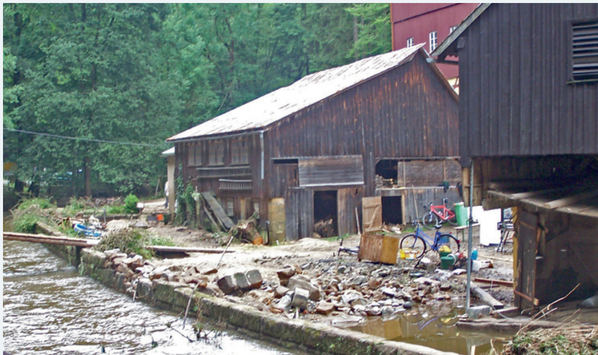
Abbildung 9-34: Die Buschmühle nach der ersten Hochwasserwelle am 07./08.08.2010 (Foto: LTV)
