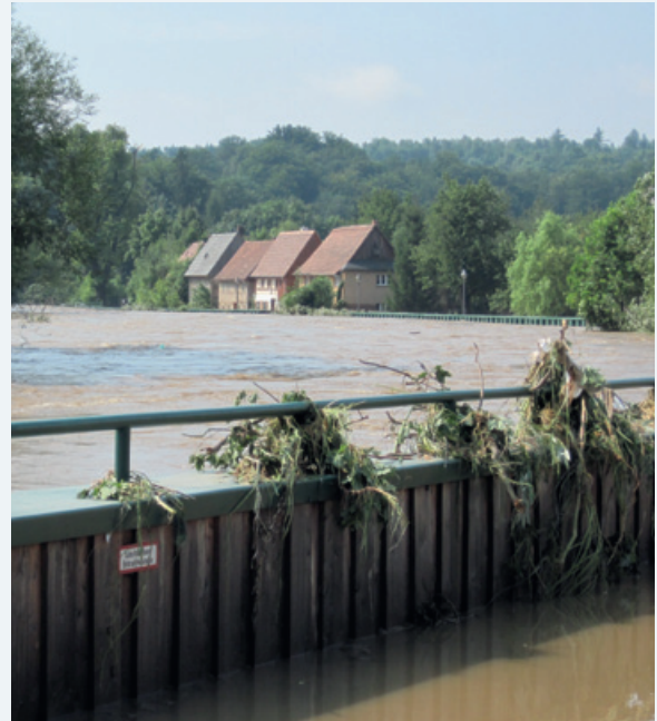
Abbildung 9-11: Überströmte Spundwand an der Klosterstraße (Foto: LTV)
