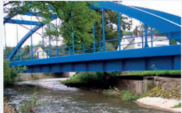
Eisenbahnbrücke „Blaues Wunder“
