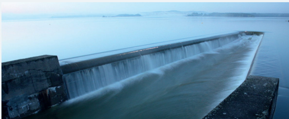
Abbildung 4-55: Hochwasserentlastungsanlage der Talsperre Quitzdorf bei Vollstau am 28.09.2010 (Foto: LTV)
