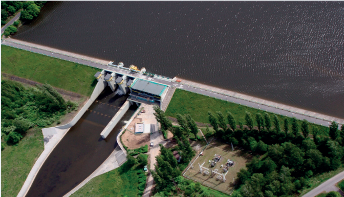
Abbildung 9-22: Talsperre Niedów an der Witka in der Republik Polen vor der Zerstörung durch das Hochwasser im August 2010 (Foto: PGE)
