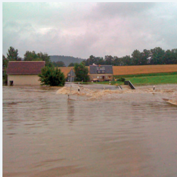
Abbildung 9-47: Zerstörung (Foto: Hr. Baldauf)
