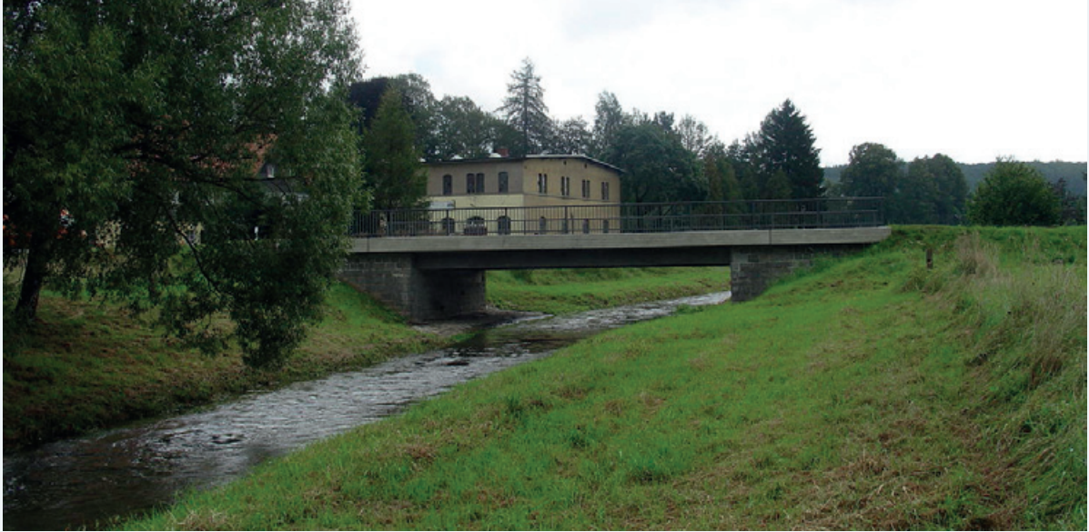
Abbildung 9-43: Vorhandenes Brückenbauwerk bis August 2010 (Foto: SBA Bautzen)
