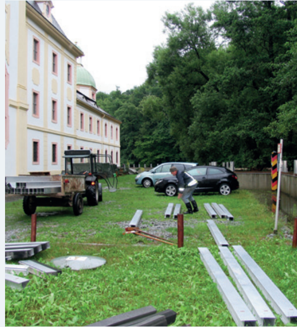
Abbildung 9-7: Ostritz Kloster. Aufbau mobiler Hochwasserschutz-elemente am 07.08.2010, gegen 14.00 Uhr (Foto: Kloster St. Marienthal)
