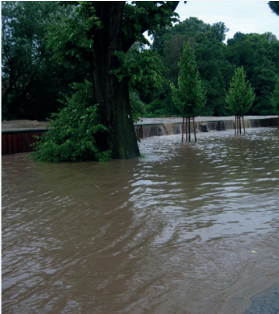
Abbildung 9-10: Überströmen der Spundwand am Franz-Gareis-Weg (Foto: LDS)
