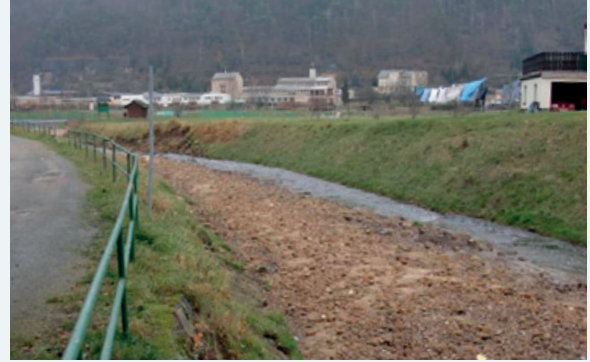
Abbildung 9-76: Geröllablagerungen im Mündungsbereich des Krippenbaches in die Elbe nach dem Hochwasser 2010 (Foto: Stadtverwaltung Bad Schandau)
