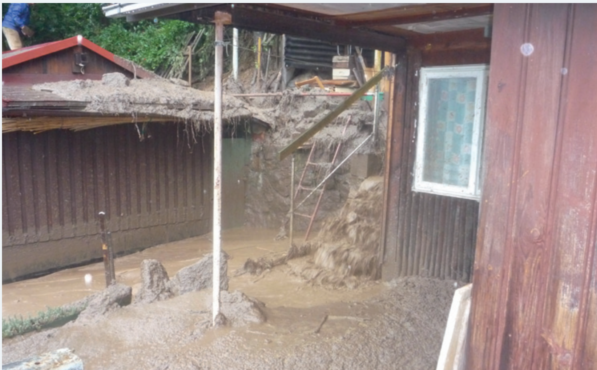
Abbildung 6-36: Teil des Schadenbereiches der großen Hangrutschung unterhalb der Festung Königstein (Foto: Feuerwehr der Stadt Königstein)
