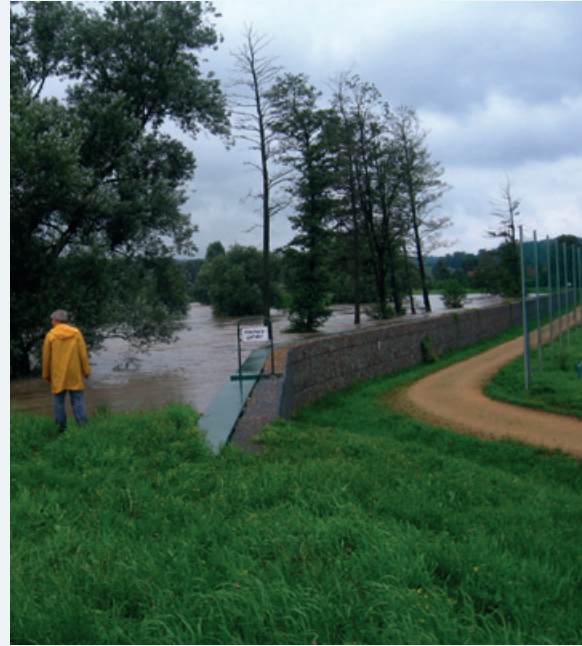
Abbildung 9-9: Kontrolle der Hochwasserschutzanlagen am 07.08.2010, nachmittags (Foto: LDS)
