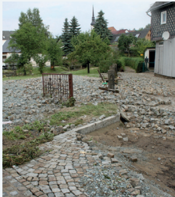
Abbildung 9-87: Hauptstraße, Finkelbrücke, nach dem Hochwasser (Foto: Gemeinde Cunewalde)
