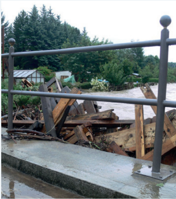
Abbildung 9-84: Verklausung an einer Brücke beim Hotel „Alten Weber“ in Weigsdorf-Köblitz (Foto: Gemeinde Cunewalde)
