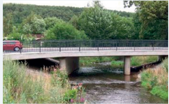
Brücke Klaffenbacher Hauptstraße
