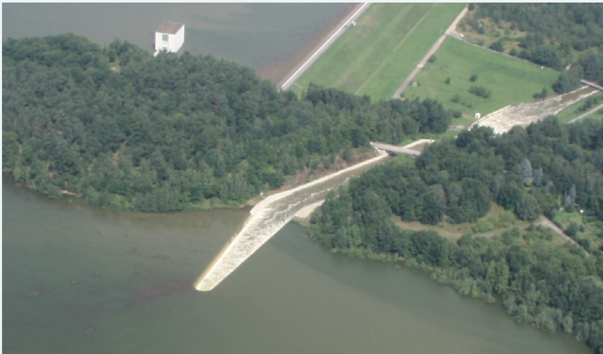
Abbildung 4-48: Abgabe über die Hochwasserentlastungsanlage der TS Bautzen am 08.08.2010 (Foto: LTV)
