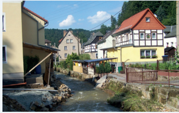
Abbildung 9-78: Nach dem Hochwasser des Krippenbachs, 10.08.2010 (Foto: LTV)
