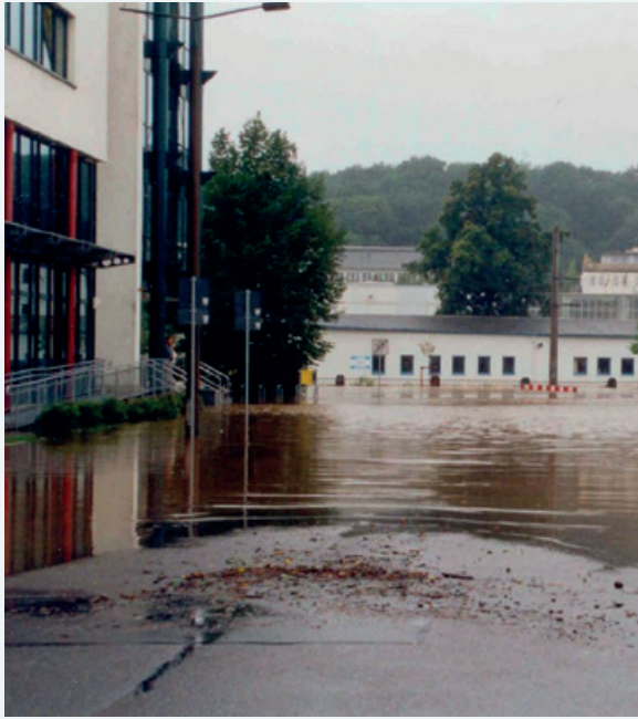
Abbildung 6-7: Chemnitz, Technisches Rathaus, Wasserstand August 2002 (Foto: Stadt Chemnitz)
