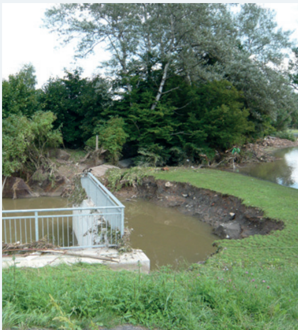
Abbildung 9-18: Ostritz, Kolk am Sielbauwerk (Foto: LTV)
