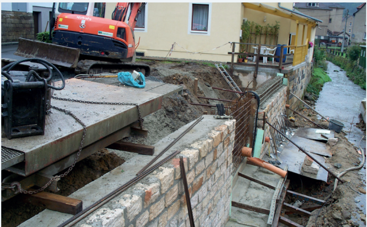
Abbildung 9-80: Endgültige Hochwasserschadensbeseitigung Sommer 2012 (Foto: Landesdirektion Sachsen)
