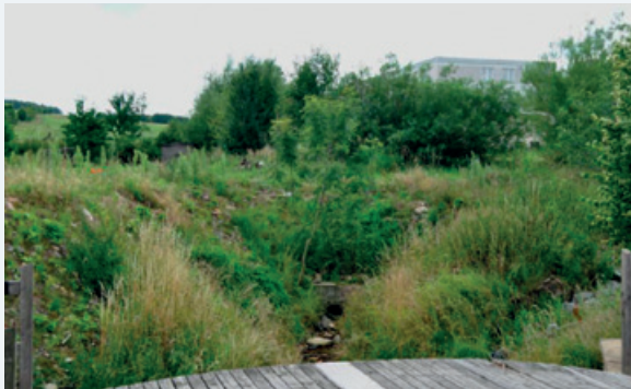
Abbildung 9-63: Feldwasser (Steinbüschelgraben) oberhalb der Olbersdorfer Straße im Normalzustand (Foto: Sieker 2012)
