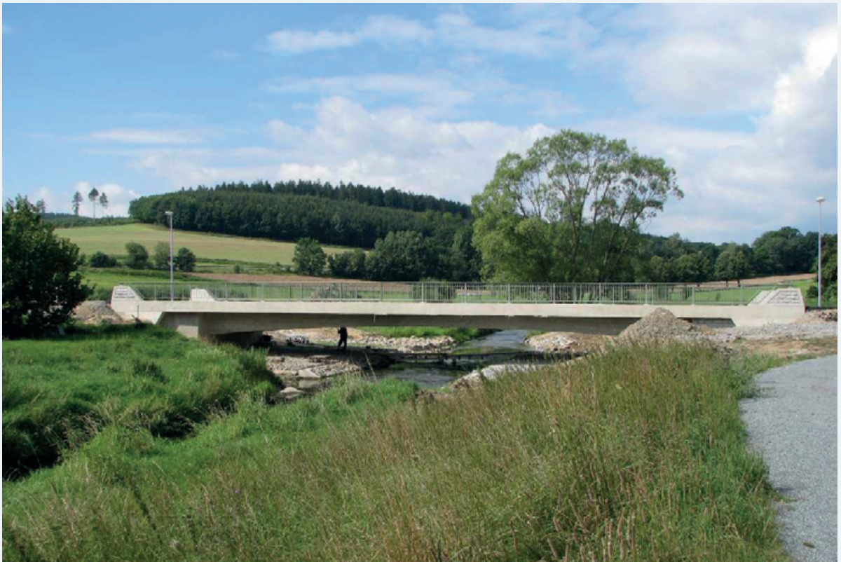
Abbildung 9-49: Fertig gestelltes Bauwerk 2012 (Foto: LRA Bautzen, Straßen- und Tiefbauamt)
